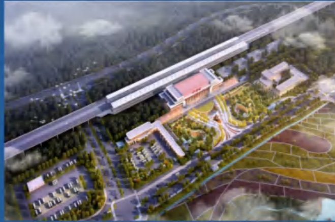
杭绍台铁路客运专线
