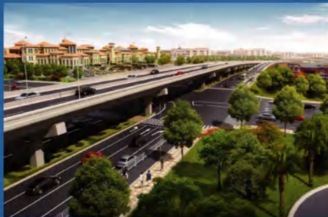
甬台温高速公路增设黄岩南城互通工程
