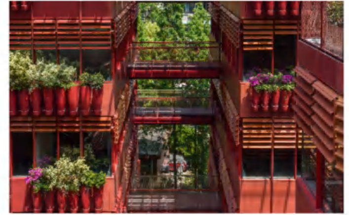
上海黄浦区恒基·旭辉天地项目
