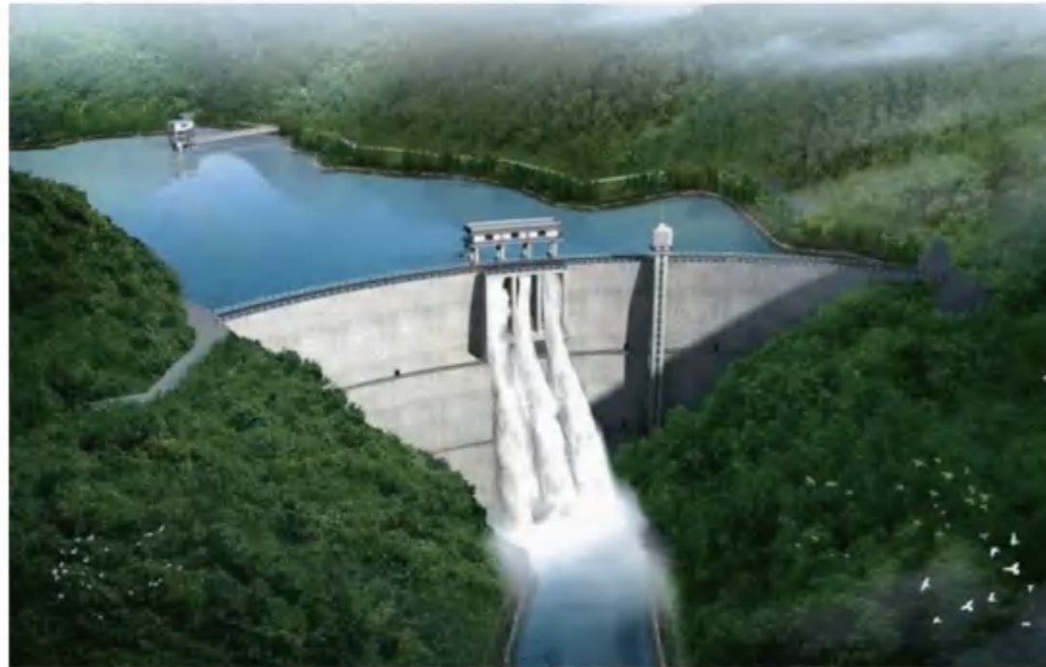
遂昌县清水源水库工程EPC总承包项目
